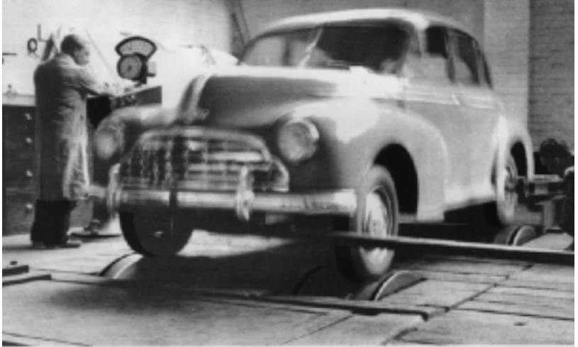
Ka ny sOxlende, der rykkes op og ned på de ujævne træer, får 5 års slid på 50 timer. De britiske veje er for gode til at give vognens den behandling, som de blot kan komme ud for i Canada, Amerika, Australien og Sydafrika. Selv om de engelske veje var dårlige nok, ville det tage for lang tid at prøve vognene. Denne maskine er derfor konstrueret, således at den på få timer koncentrerer flere års kørsel.
