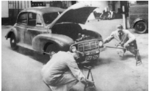
Under de 20.000 km prøve-kørsel blev tjekket for diverse. Her testes hjulindstillingen på en Minor.
