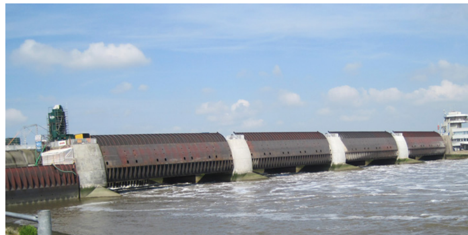
Anlægget omkring Ejderdæmningen er stort – her er selve sluserne.
