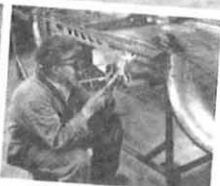
Astogensvejret af bundkonstruktion.
